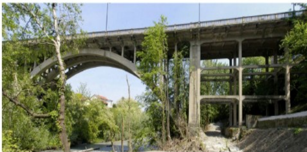
Foto della Sezione Longitudinale Ponte vista da monte
